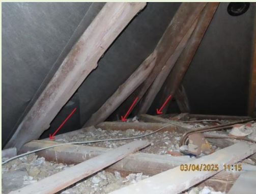
Tagkonstruktion set indefra, borebiller
