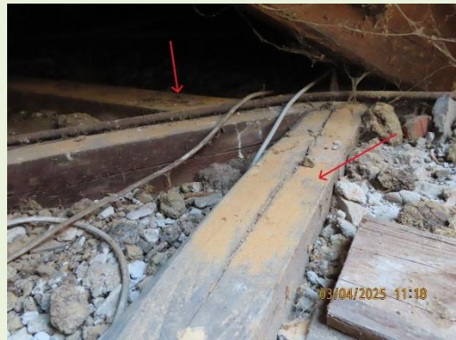
Tagkonstruktion set indefra, borebiller
