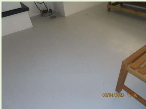
Betongulv i kælder - malet
