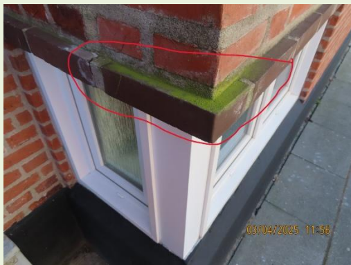
Mørtelfuger og inddækning
