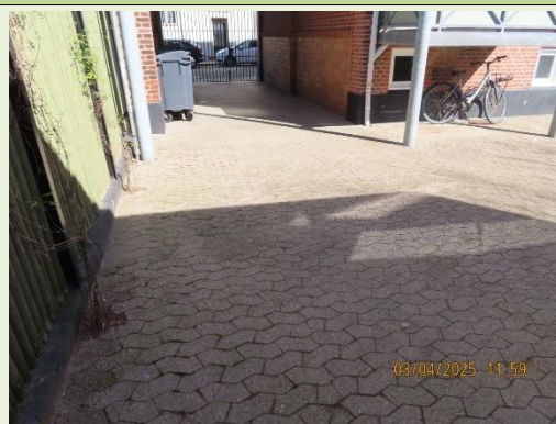
Belægning ved port gennemgang - fliser
